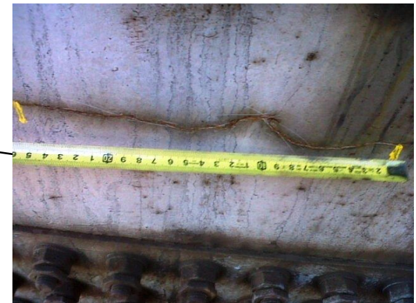
Vida remanente de grúas de puerto
