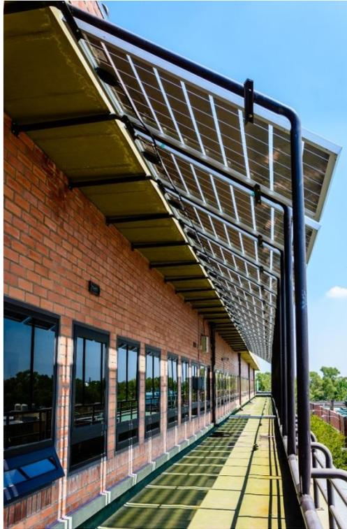
Figura 25: Pérgola FV en el Edificio Tandar del Centro Atómico Constituyentes.
