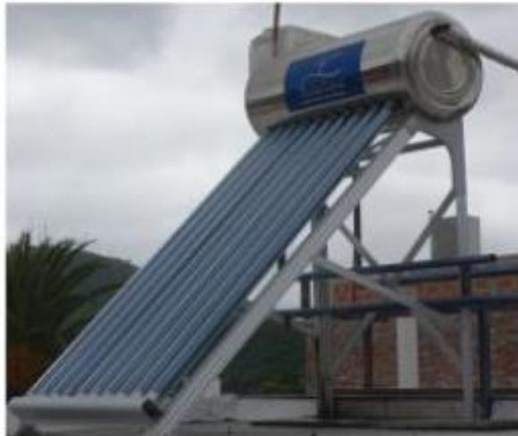
Figura 5. Colector solar de tubos de vacío de tipo directo con acumulador de 100 litros
