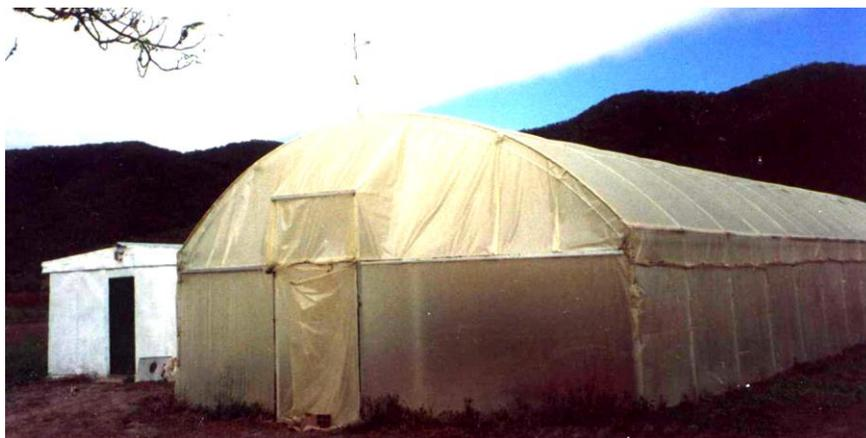
Fig. 6. Secador solar tipo Invernadero
