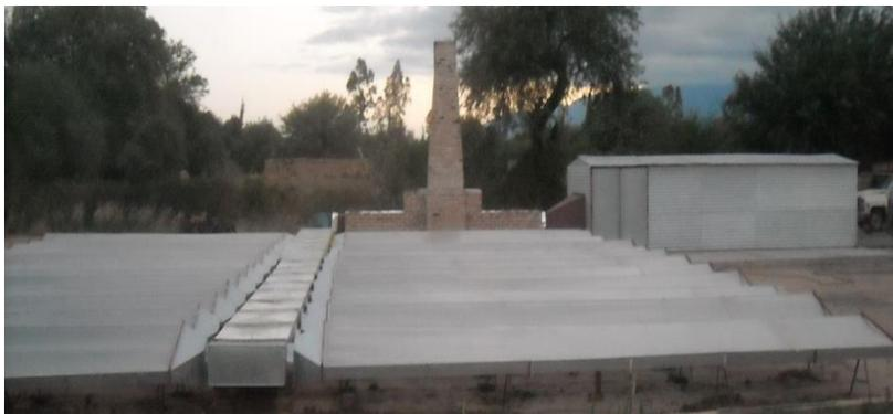
Fig. 11. Secador híbrido solar-biomasa, indirecto, tipo túnel
