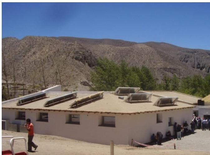
Fig. 5. Colectores solares instalados en el Colegio Secundario Albergue de Montaña de El Alfarcito, Salta.
