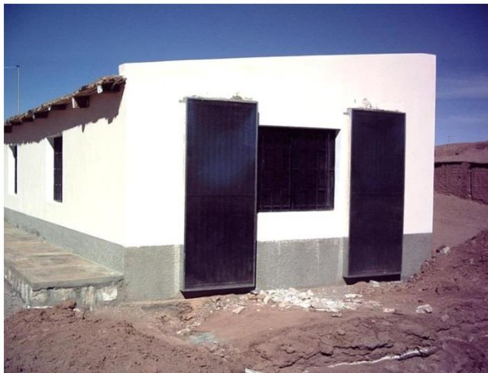
Fig. 4. Instalación compuesta por 2 colectores calentadores de aire por loop convectivo en el taller de artesanos de la localidad de Tolar Grande, Salta.
