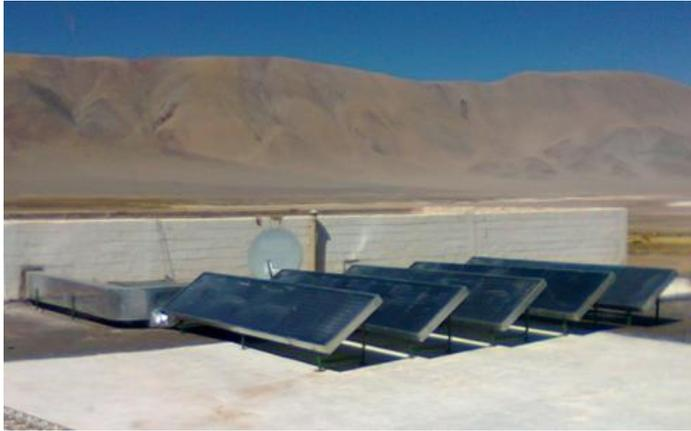
Fig. 6. Instalación de calefacción solar para el Salón Municipal de Tolar Grande, Dpto. Los Andes, Salta.
