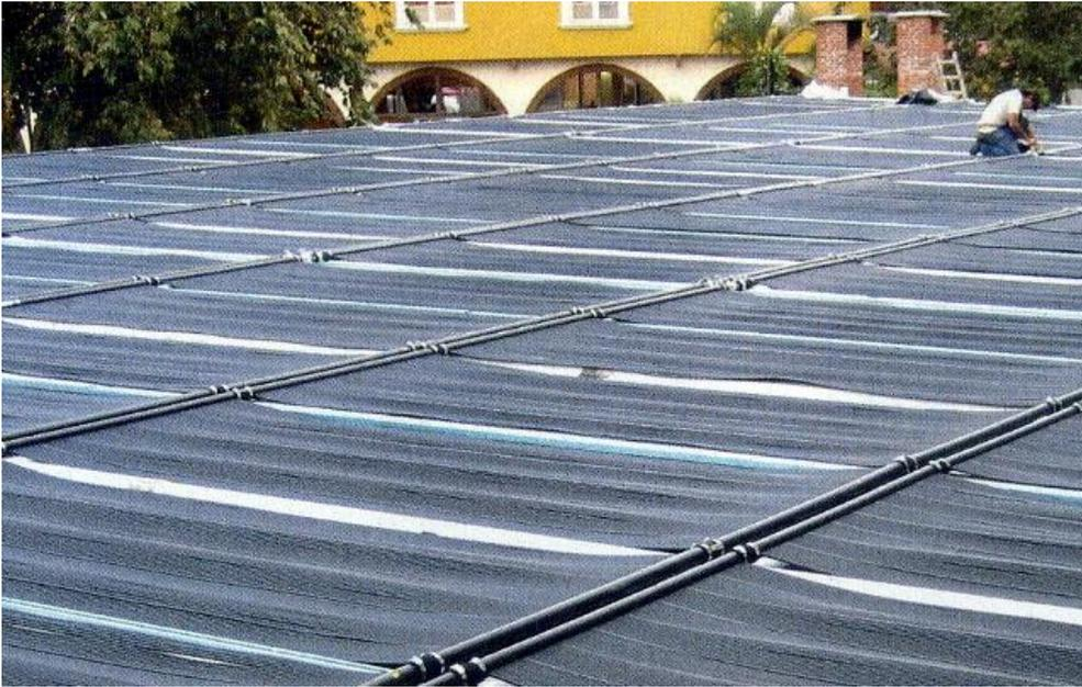
Figura 3. Colector sin cubierta de 640 m<sup>2</sup> de área para el calentamiento del agua de una piscina
