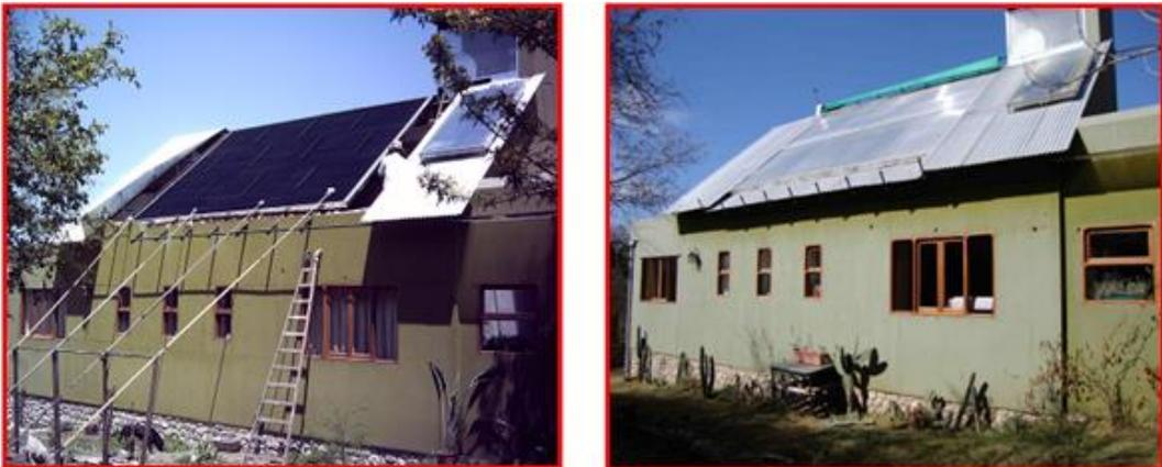
Fig. 7. Techo-colector solar para la calefacción de la vivienda SAMIRI.
