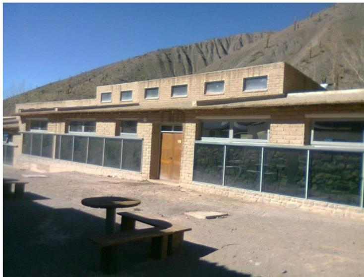
Fig. 2. Muros colectores-acumuladores. Colegio Secundario Albergue de Montaña “El Alfarcito”, Quebrada del Toro, Salta, Argentina.
